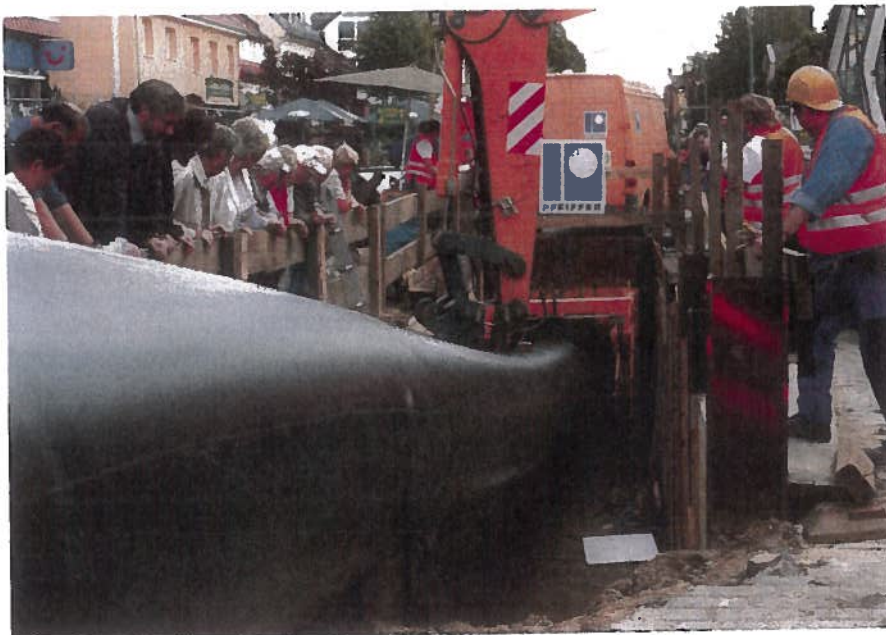
Fachbesucher der Messe Wasser Berlin 2011 informierten sich am Baustellentag über die grabenlose Sanierung der alten Abwasserdruckleitung auf der Frankfurter Allee. Links: Mit dem Swageline-Verfahren wird ein Kunststoffschlauch eingezogen. Rechtes Foto: Philip Singer, Niederlassungsleiter der bauausführenden Ludwig Pfeiffer GmbH (r.), erläuterte den Gästen die technischen Details.
