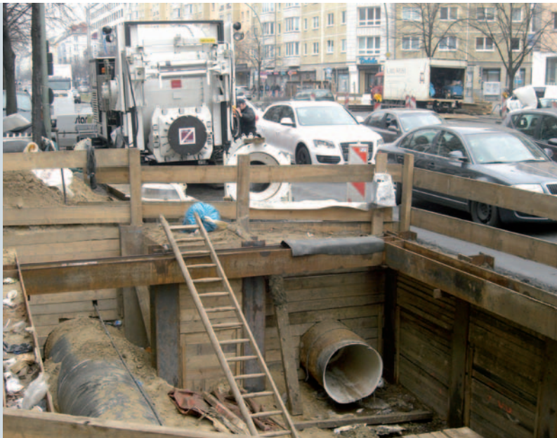
BILD 8: Baugrube mit paralleler Leitungsführung der ADL DN 1000 und DN 750
