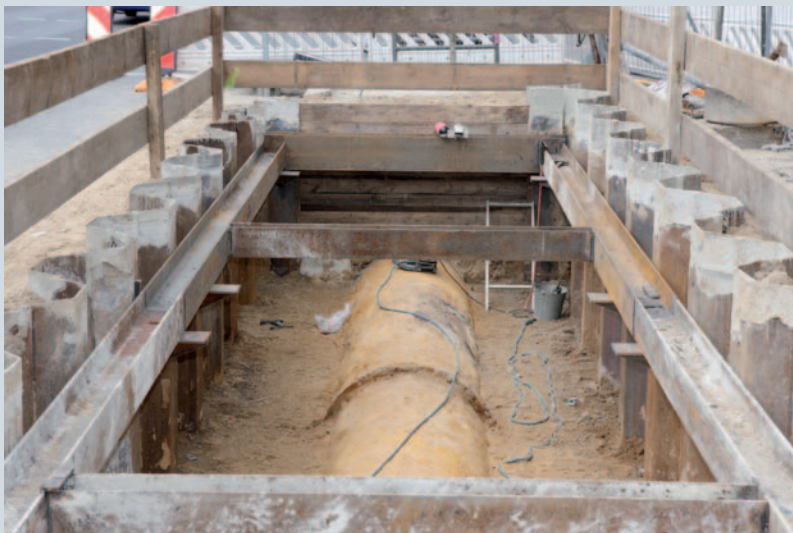
BILD 9: Wasserdichte Wand-Sohle-Baugrube des zweiten Bauabschnitts. Die ADL DN 1000 ist noch in Betrieb und daher erst teilweise freigelegt.
