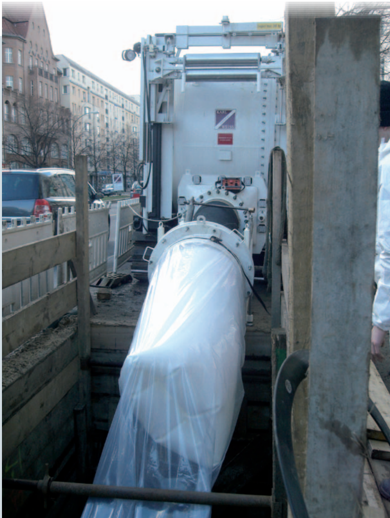
BILD 11: Reversion des starline®HPL-S-Gewebeslauchs. Im Bereich bis zum Rohranfang wird das Austreten von Klebstoff aus dem bereits umgestülpten Gewebeslauch durch einen transparenten Schutzschlauch verhindert
