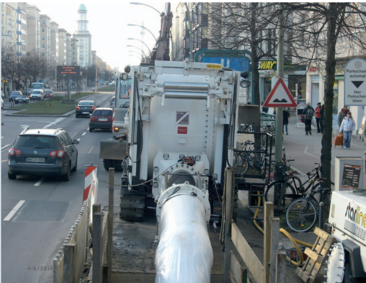
BILD 1: starline®HPL-S- Gewebeschlauch- einbau DN 750 in Berlin, Frankfurter Allee (Feb. 2011)
